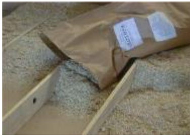
Vrac en combles perdus
