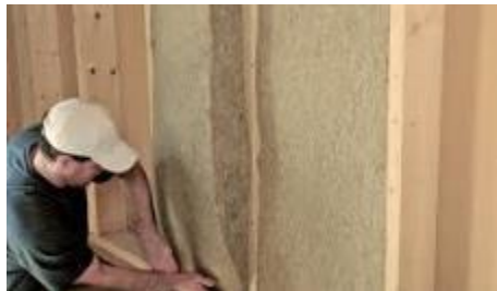
Remplissage d'ossature bois et isolation intérieure
