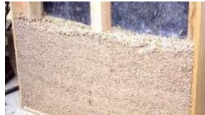
Banchage en doublage & cloison
